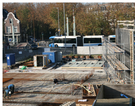
Aan het Ledig Erf wordt eindelijk druk gebouwd.
